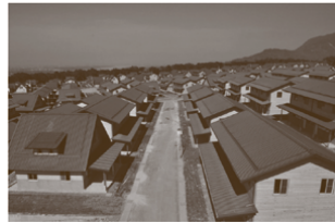
民國99年 禮納里部落永久屋完工。
